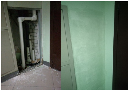
Замена участка трубы 6эт. и восстановление отделки
