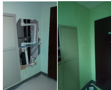
Замена участка трубы 7эт. и восстановление отделки
