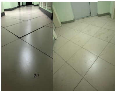
Восстановление плитки 12эт.
